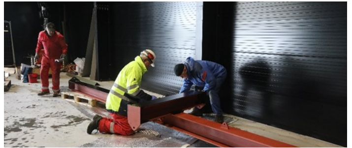
For å spare tid ble bjelkene levert kun med grunning, slik at vi selv la på svart lakk for at de skulle harmonere med hallen
