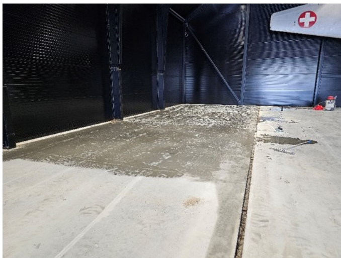
Med flyen i taket blir gulvet i den nye hallen vasket. Deretter må det oljes for å binde støvet fra betongen.
