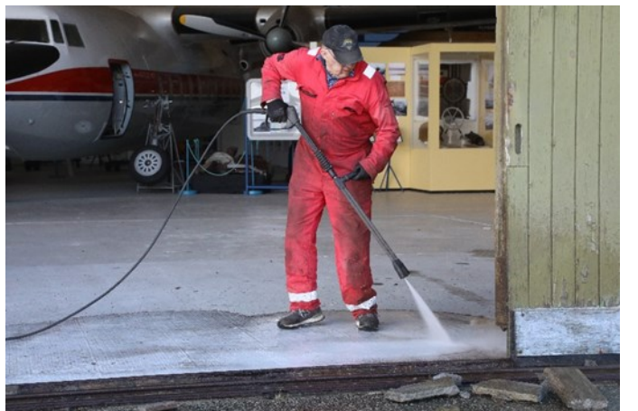
Deretter ble det høytrykkspylt mellom skinnene.
