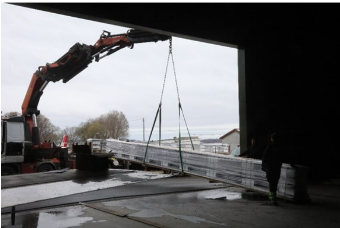
Til slutt kom den etterlengtede porten. Som så måtte ha noen dager for å bli montert.
