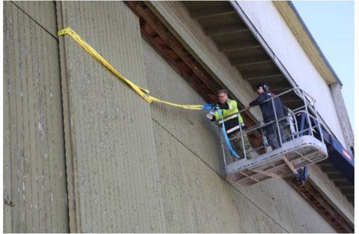
Portelementene ble trukket tilbake i posisjon med lastestropper. Her står Rolf Lund og Mathias Bolgen i liften. Mathias er elev ved Sola vgs. Det er fint å se at vi også kan tiltrekke oss yngre entusiaster.
