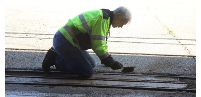
Først ble så mye støv, sand og annen skitt rensket vekk. Her er Kjell Sivertsen i gang med rensing mellom skinnene.
