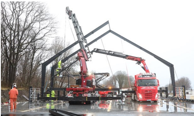
Så startet arbeidet med reisverket til utstillingshallen.
