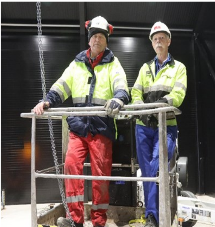
Da gjensto bare å ta ned vinsjene og feste hjulene til tverrbjelken.
