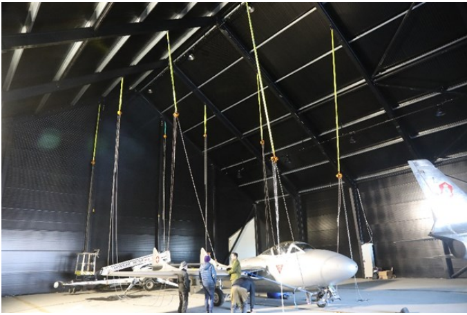
Og til slutt henger 8 vinsjer fra taket
