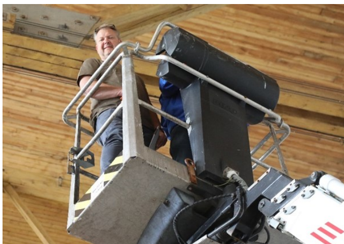
Så ble treverket inspisert av en bygningsteknisk ekspert,
