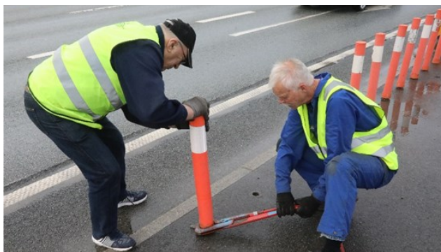
Første punkt på forberedelsene var å fjerne speringene langs veien. De fleste ble fjernet ganske greit, men de var noen som måtte fjernes med rå makt
