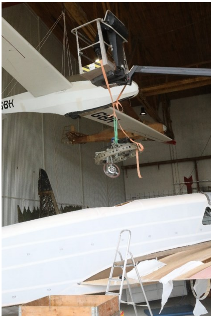
Da var tiden kommet for å montere MG tårnet. Det var ikke kran tilgjengelig, en lift måtte gjøre tjeneste som kran
